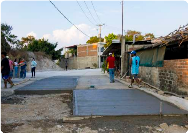
Pavimentación hecha por ArcelorMittal México, 2025
